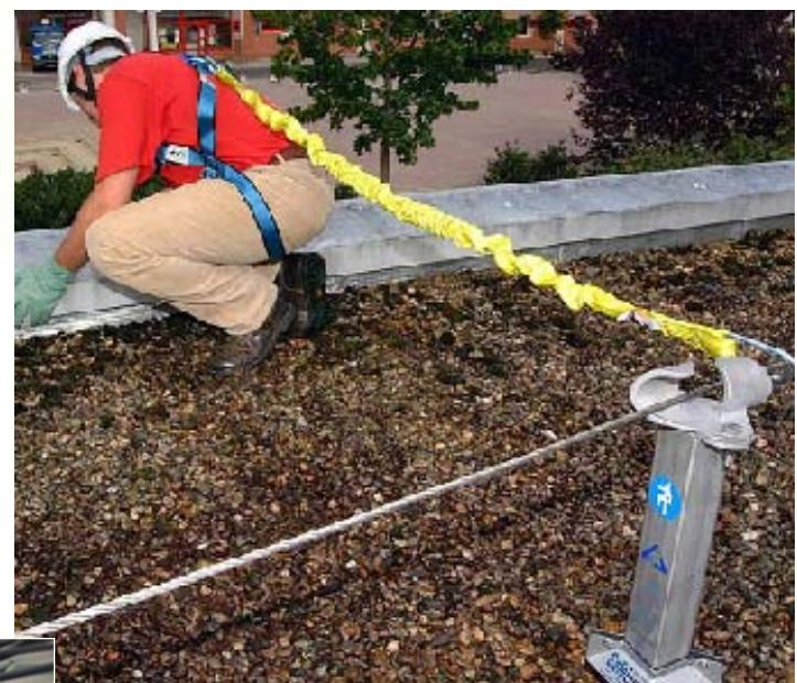
شکل ۵۷- محدود کننده با اتصال یک طناب
